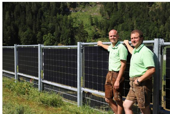
Beim Betrieb von Familie Rohrmoser in St.Martin bei Lofer, nämlich „Herberts´s Bio Freiland Eier“ wurde für 1000 Bio-Legehennen ein 320m langer Solarzaun mit einer Leistung von 52,9 kWp errichtet, dieser kann bei dieser Gelegenheit bis ins Detail begutachtet und geprüft werden. Für Speis und Trank ist am 6. September bestens gesorgt. Familie Rohrmoser und Elektrotechnik Leitinger Photovoltaik GmbH freut sich auf euer Kommen.
